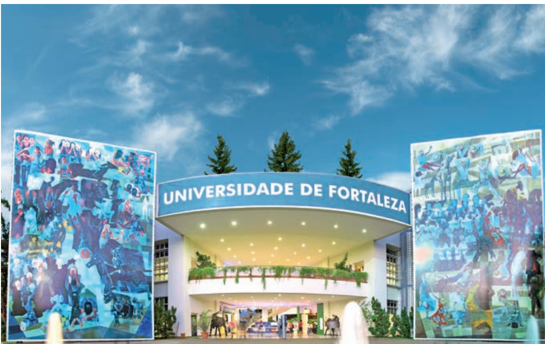
Fachada do Centro de Convivência.
